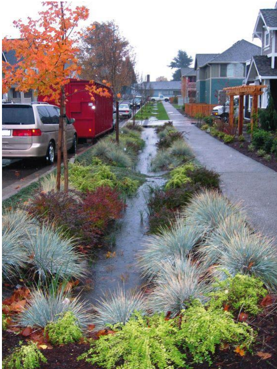
2 TRINCHERA DE CAPTACIÓN DE AGUA CON VEGETACIÓN NATIVA Y PUENTES DE CONEXIÓN.
